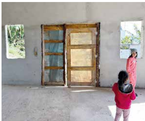
Cappella Sant'Oscar Romero in costruzione.
